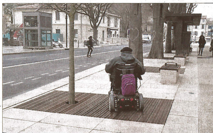
■ Oui ! En certains points des boulevards, un « plancher » entoure les arbres, sur le même plan que le trottoir. « Ça, c'est bien », note Michel.
